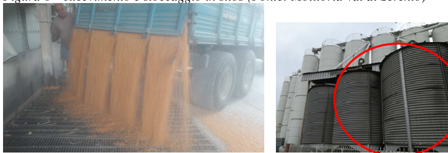
Figura 8 – Ricevimento e stoccaggio in silos (Fonte: Molitoria Val di Serchio)
